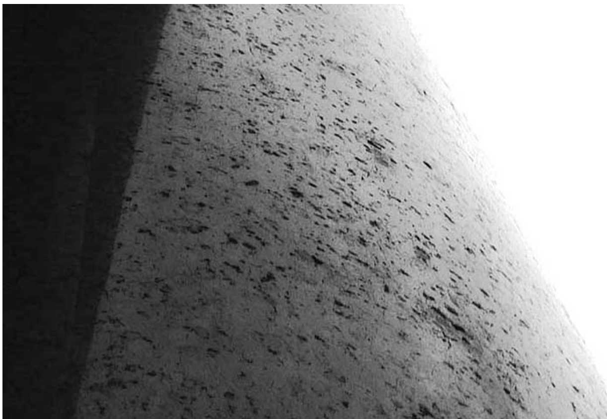
Рис. 14. Каверны на колоннах Исаакиевского собора
