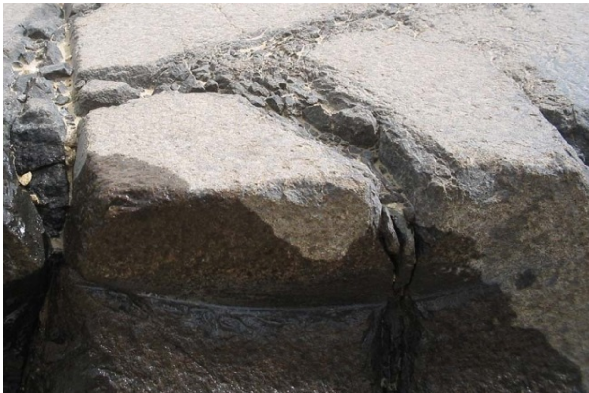
Рис. 9-ц. След дисковой пилы на блоке в храме Усеркафа
