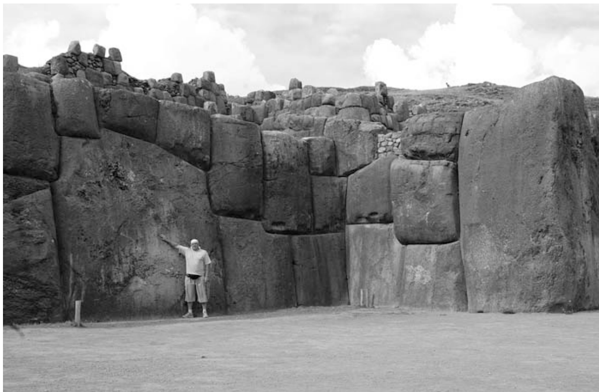
Рис. 12. Каменные монолиты в Саксайуамане
