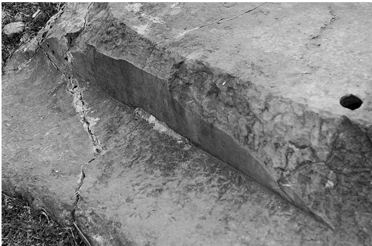
Рис. 20. Следы распила на блоке в Тиринфе
